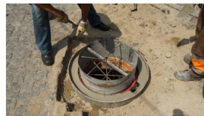
Filling of mould with BETÃO-S ESTRUTURAL RÁPIDO
