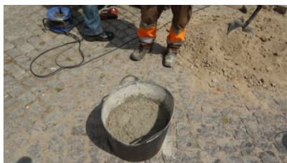
Mixing of BETÃO-S ESTRUTURAL RÁPIDO
