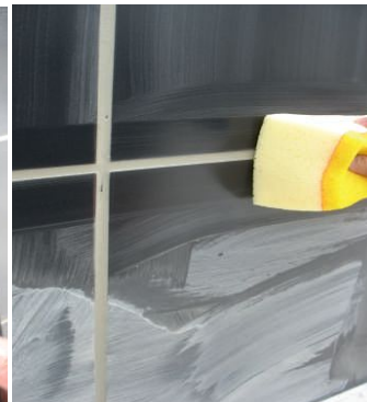
Nettoyage du surplus de mortier
