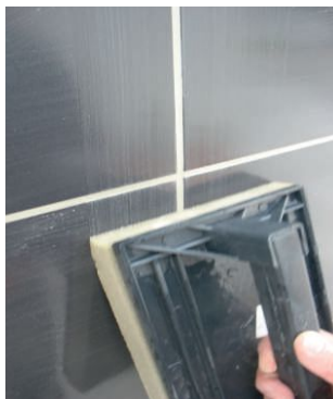
Nettoyage du surplus de mortier
