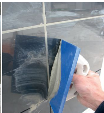
Jointoiement avec ADHERE Cor 05
