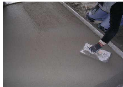
Talochamento da superfície final
