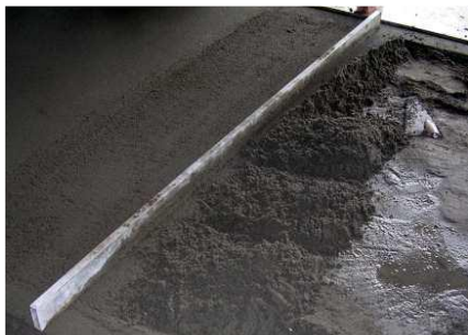
Colocação da argamassa
