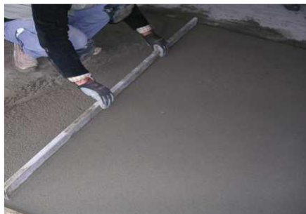
Regularização com régua metálica
