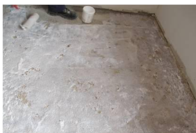
Aplicación del primario MICROART AD 21
