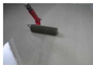
Uniformizar la superficie c/ rodillo aireado
