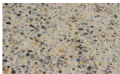
Aplicación de B-REPARA PROTEÇÃO AD 40
