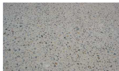
Aspecto final de la superficie tratada
