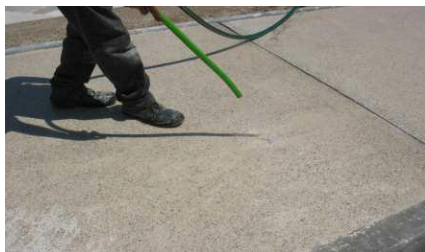
Limpieza de la superficie
